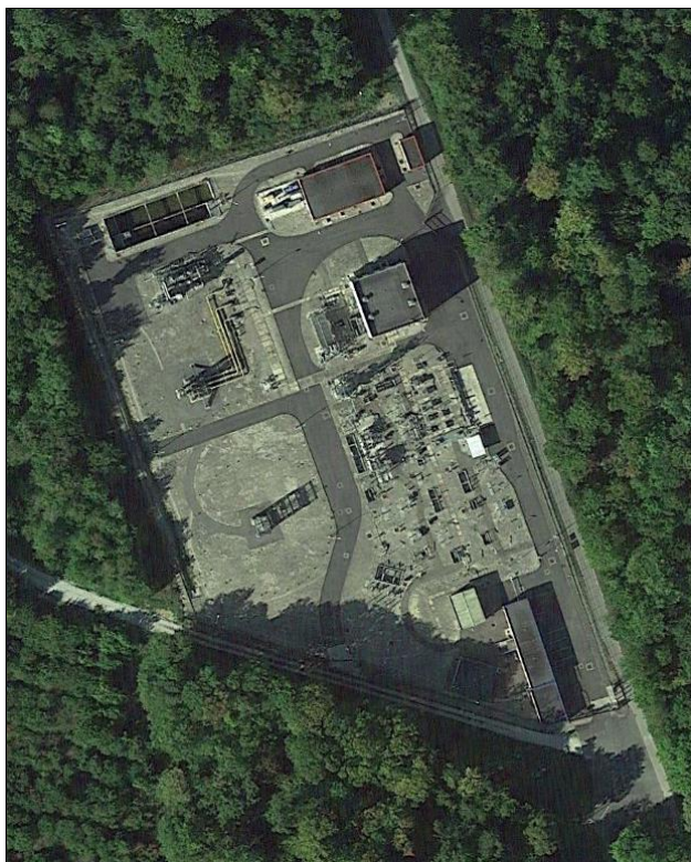
Figure 5 : les installations de Trois-Fontaines, de la société STORENGY
