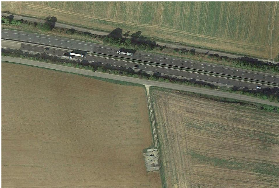
Figure 3 : le poste gaz de GRTgaz à la Houquette, sur le gazoduc de l'ouest lorrain (la route est la RN 4)
